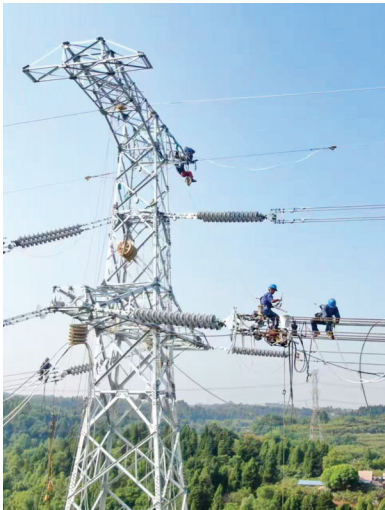
电力工人高空作业。
