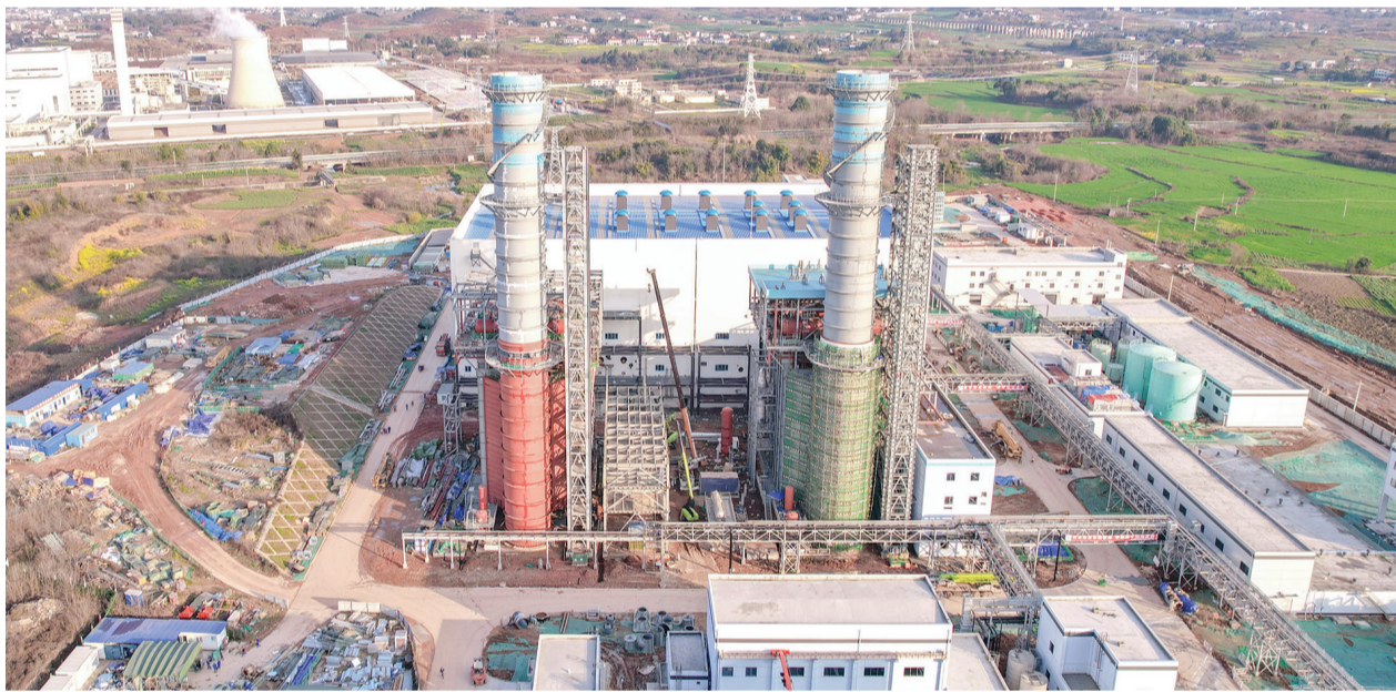
项目建设现场。
