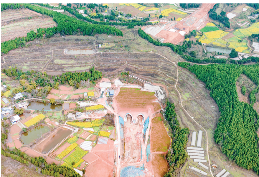
建设中的双东大道。
