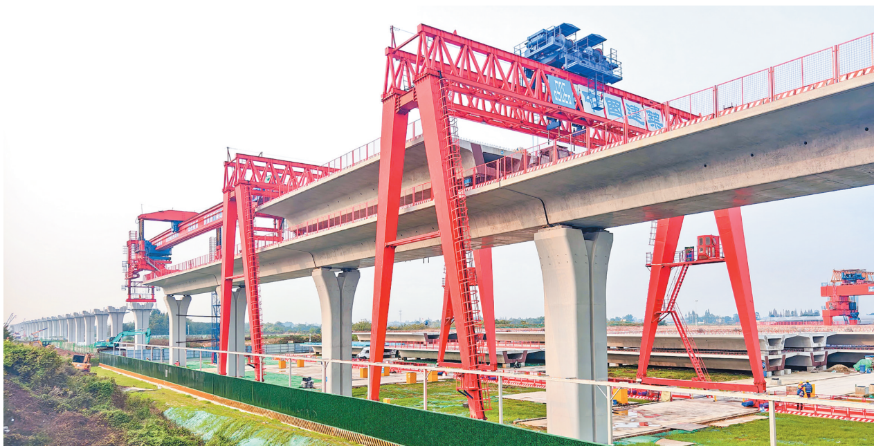
S11线高架段首片预制梁正式架设。
