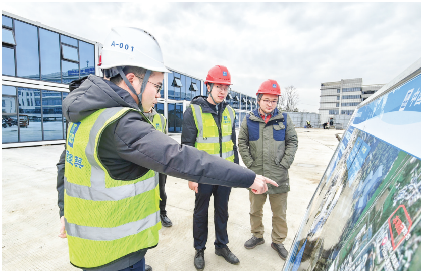
施工方正按计划推进项目建设。
