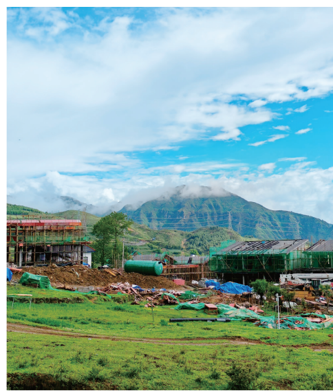
南箐镇小相岭村相岭雪村集体经济民宿施工过程
