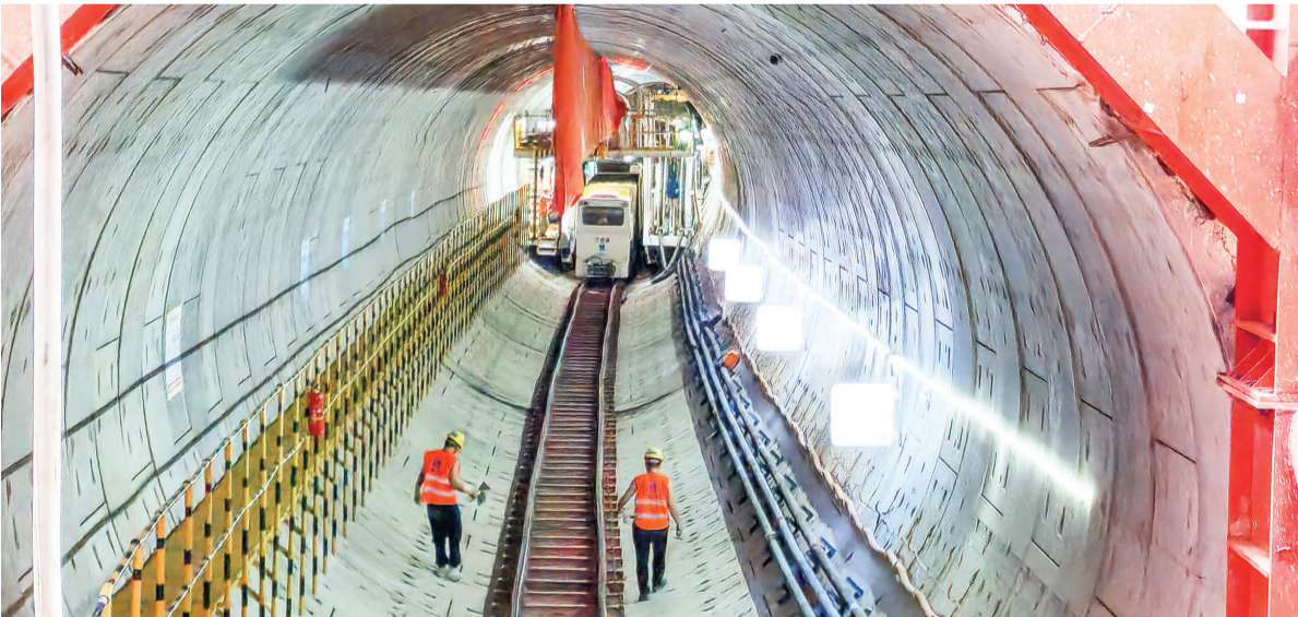
“成德1号”正在施工。
