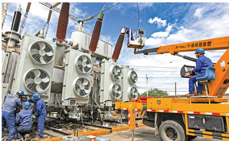
检修员在220千伏五里堆变电站开展主变散热器更换、主变主体试验等工作。
