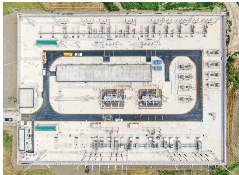
220千伏蒙阳变电站成功带电投运。周斌 摄
