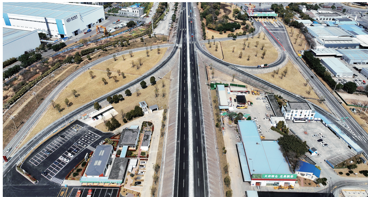
提升后的成绵高速路面面貌焕然一新。 本报记者 付帅 摄
